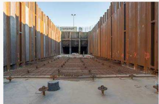
▲ Het testcentrum in aanbouw in de Flakkeese Spuisluis © Dirk Jan Gjeltema
