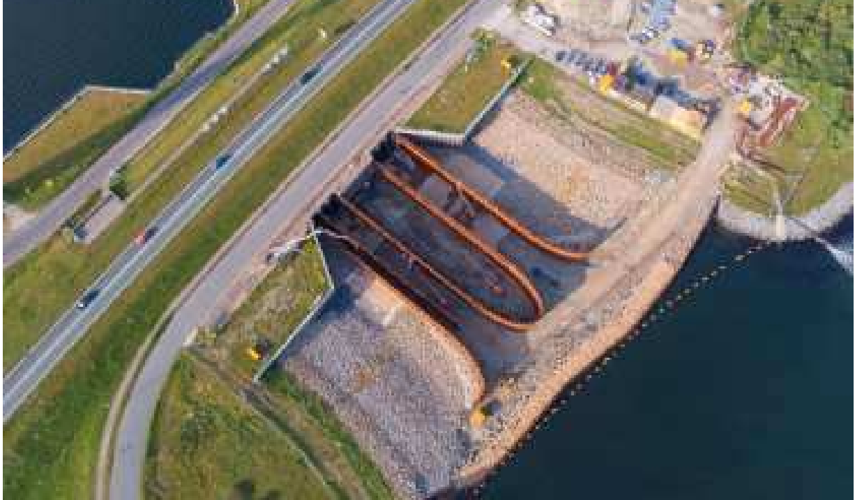
Wanden van de stromingsgoten geplaatst
