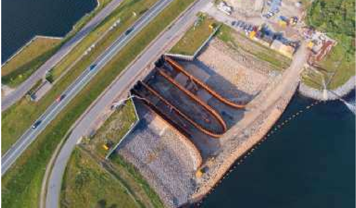
Wanden van de stromingsgoten geplaatst
