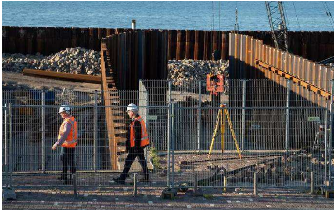
▲ De bouw van het testcentrum in de Flakkeese Spuisluis, twee jaar geleden ©Dirk-Jan Gjeltema
