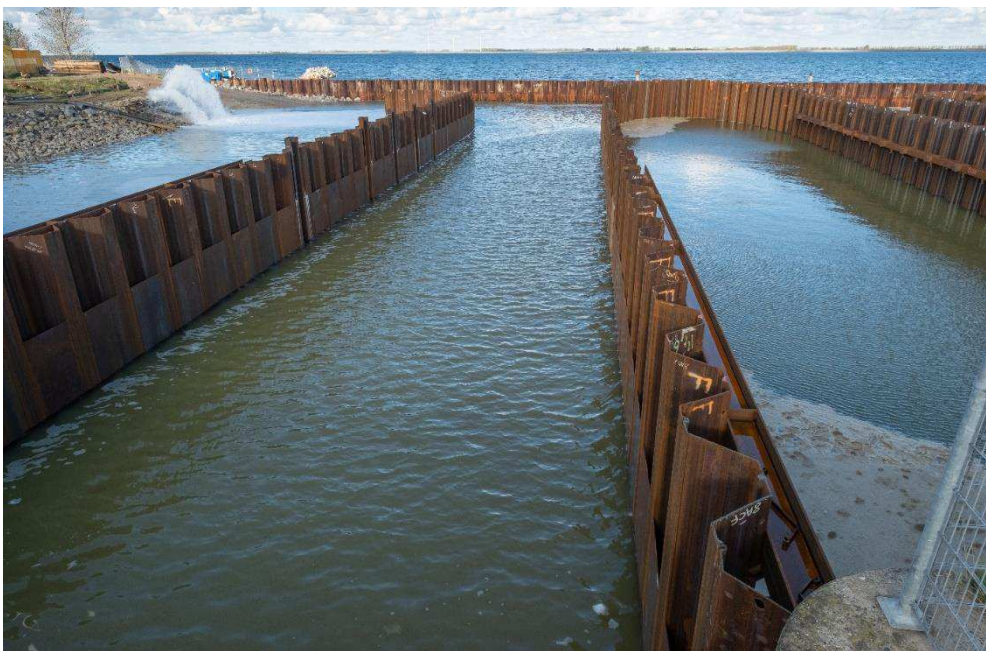
Bouwput laten vollopen op gecontroleerde wijze
