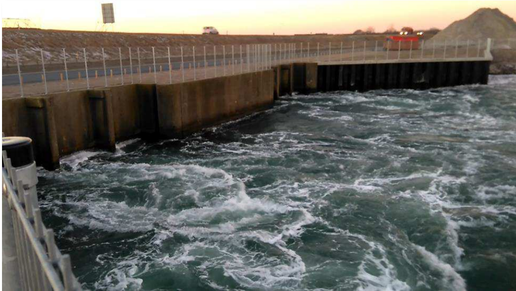
Vorbereidende fase afgerond: Spuisluizen operationeel
