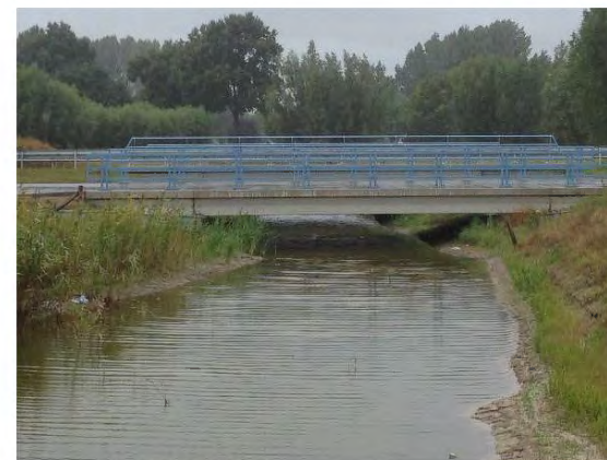
brug met doorlopende oever
