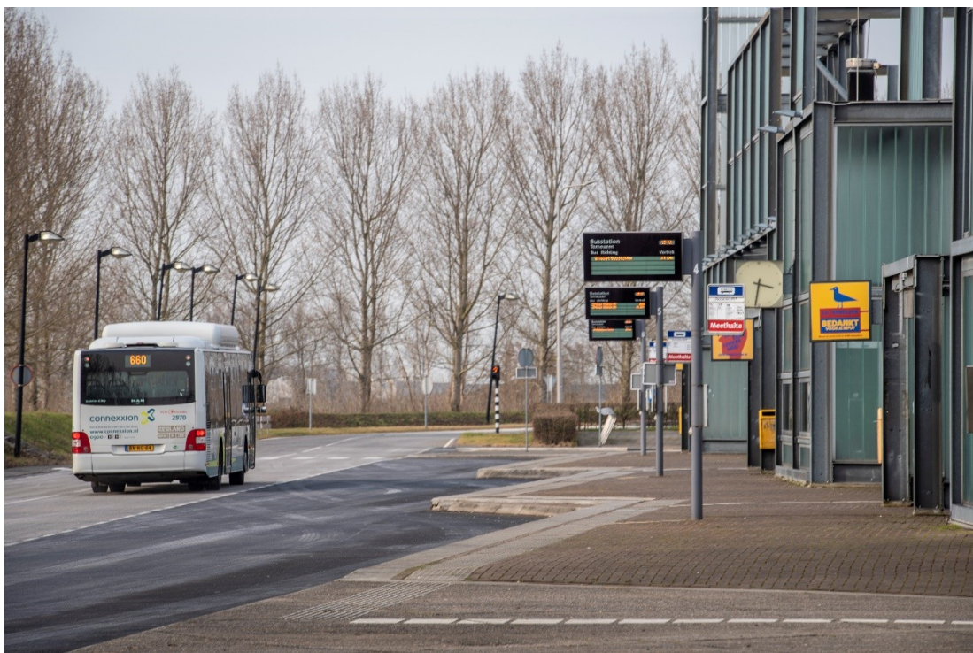
Figuur 16: Busstation Terneuzen Westerscheldetunnel
