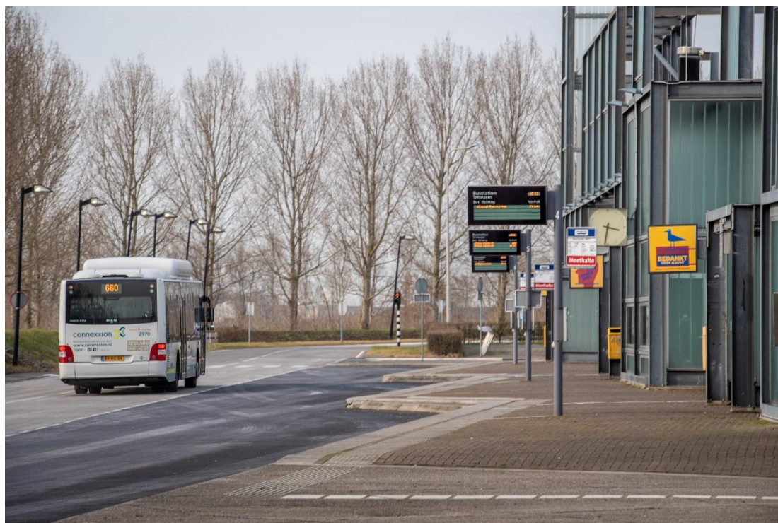
Figuur 21 Busstation Terneuzen Westerscheldetunnel
