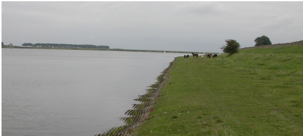
Figuur 2.8 De oever van het plangebied wordt beschermd met doorgroeistenen.
