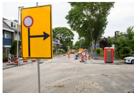
Werken in de openbare ruimte
