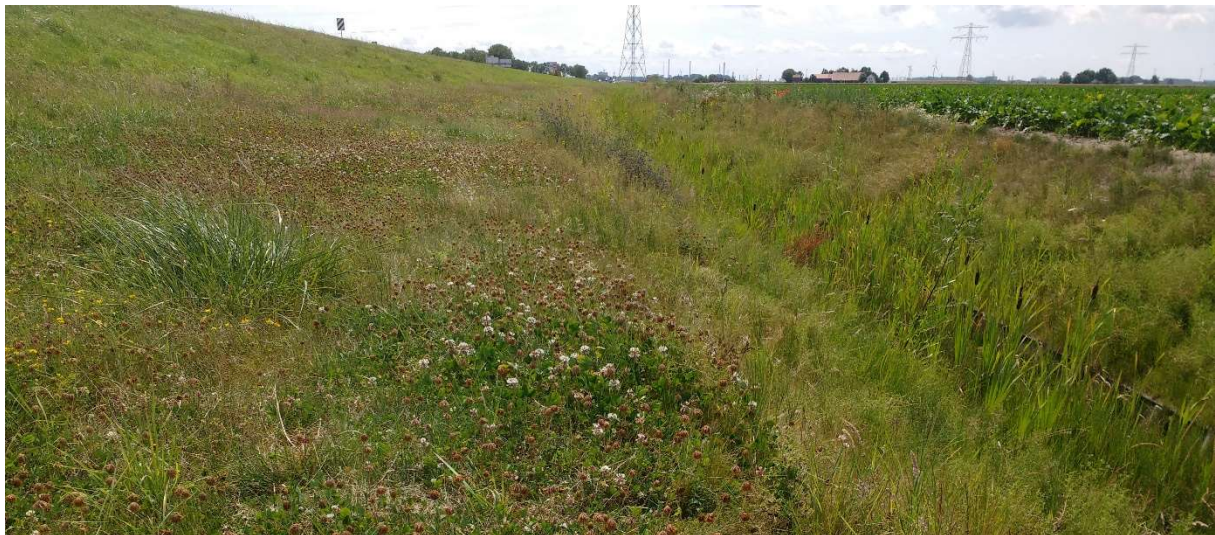
Het talud van de Sloeweg op 12 juli 2019
