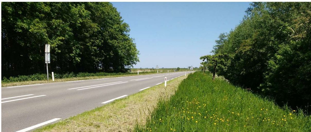
Een deel van de berm ligt beschut tussen bos en hagen
