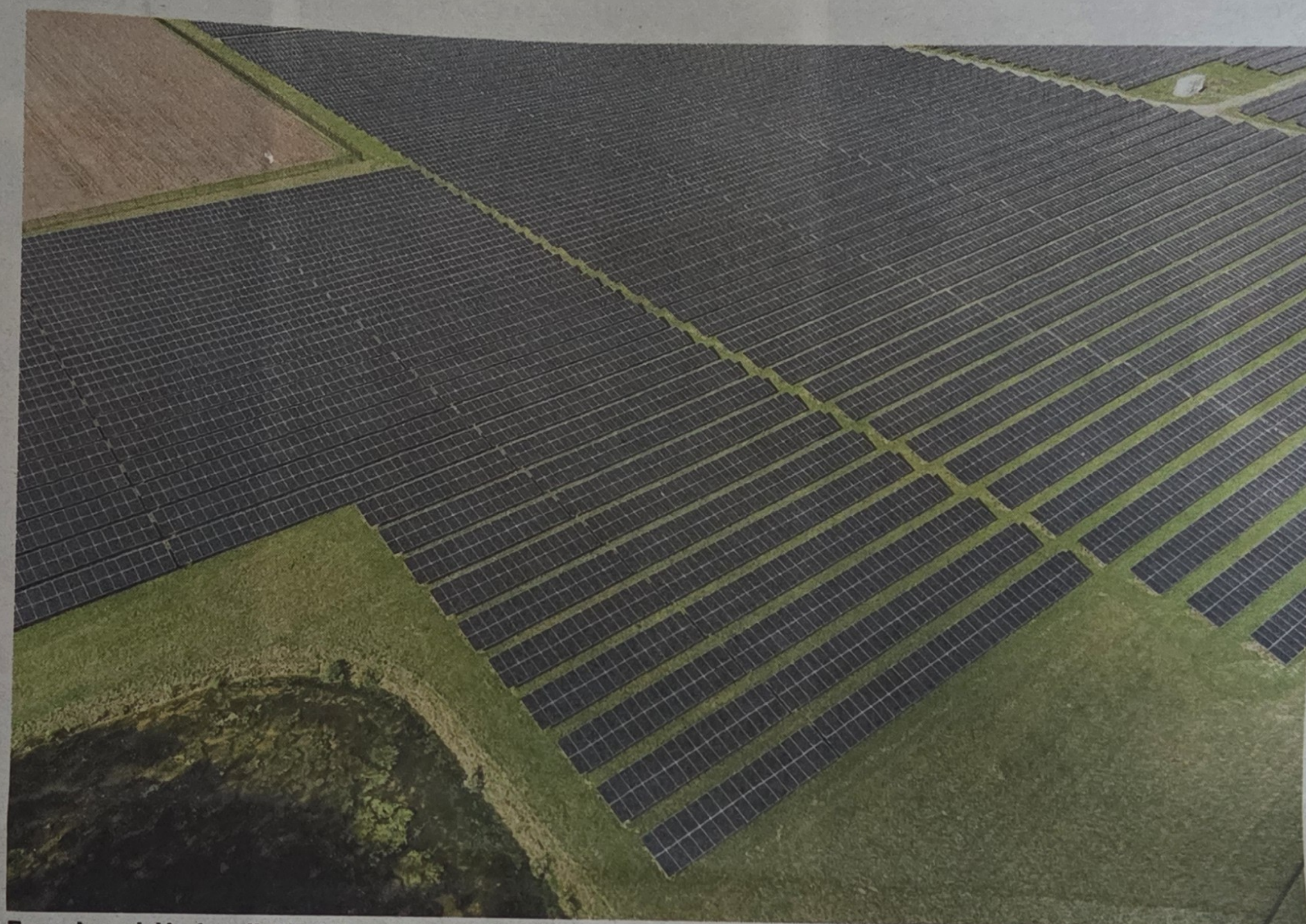
Energiepark Haringvliet Zuid van Vattenfall.
