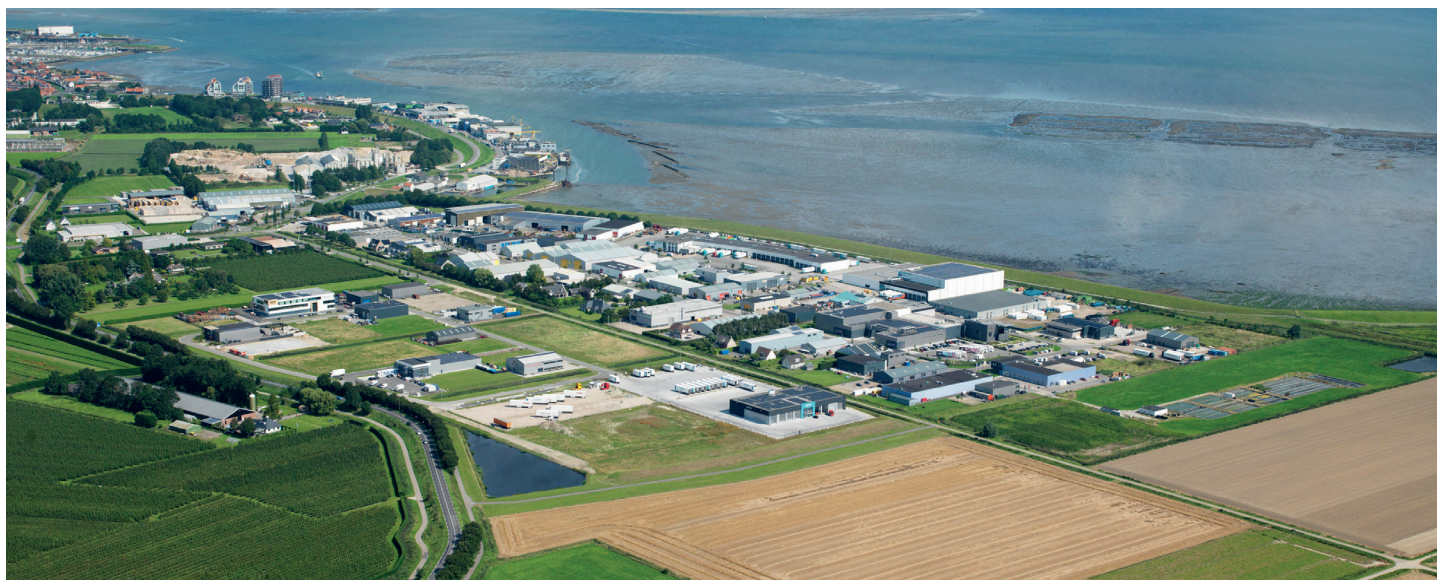
Bedrijventerrein Olzendepolder in Yerseke
