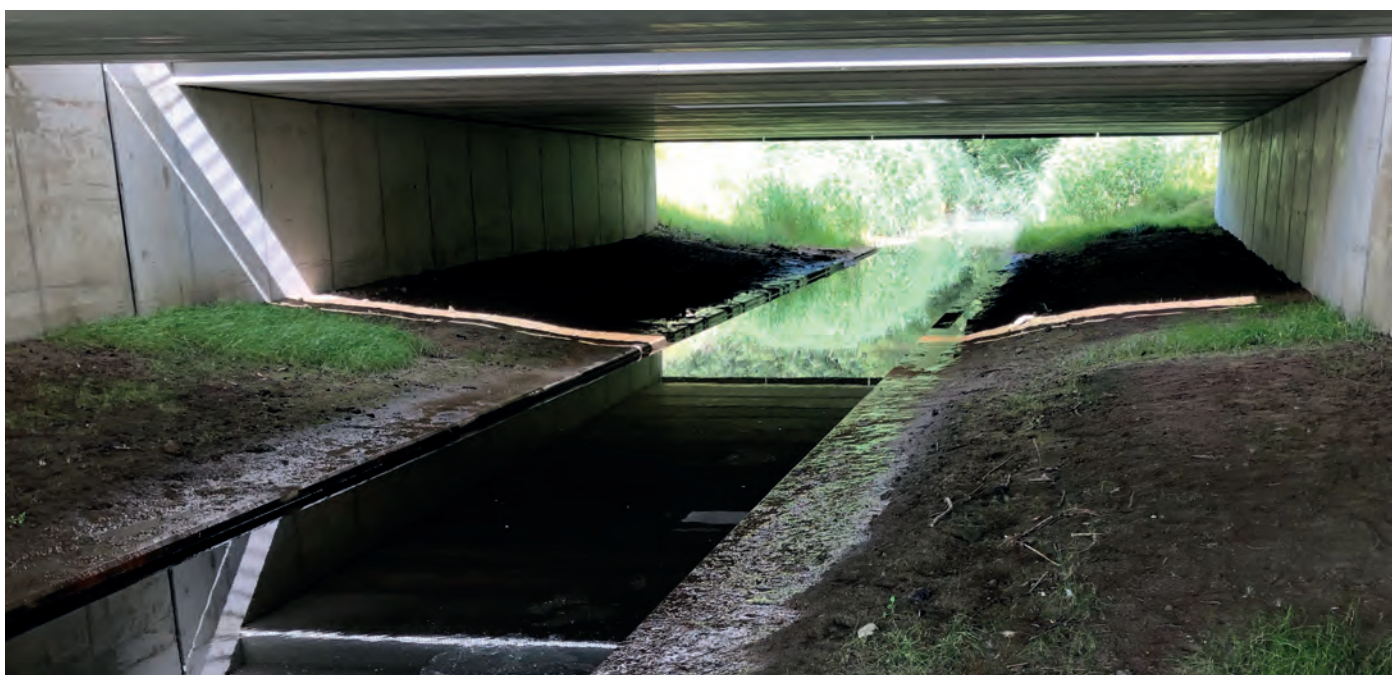
faunapassage onder viaduct
