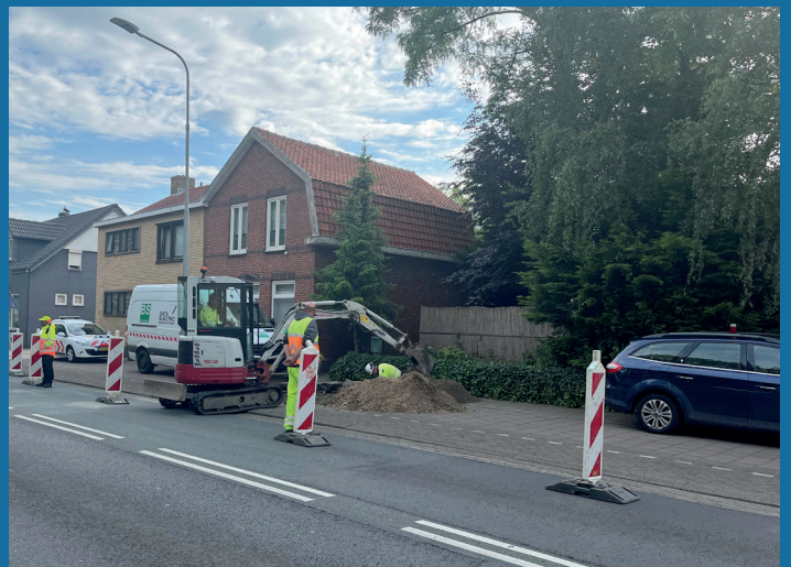
Voorbereidende werkzaamheden kabels en leidingen
