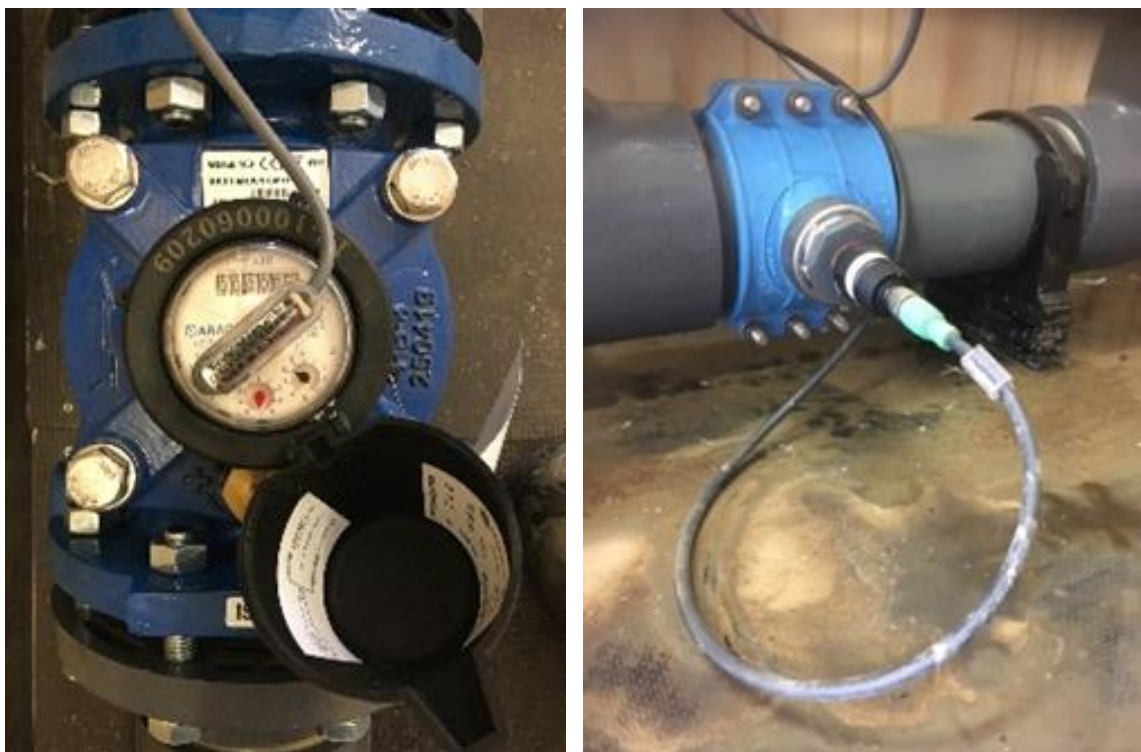
Figuur 2-18: Watermeter op leiding (links) en EGV-sensor op leiding (rechts).
