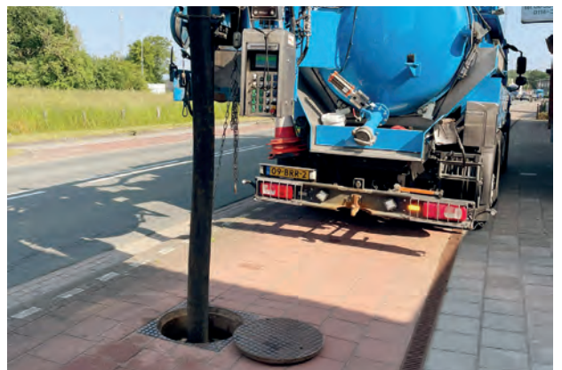
▲ Werkzaamheden aan het riool
