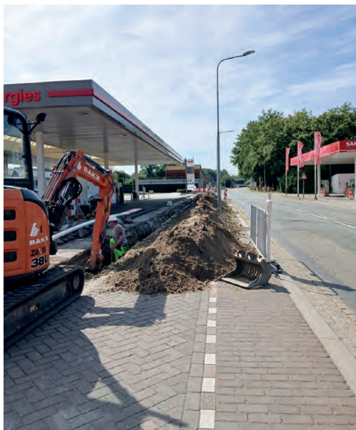
▲ Werkzaamheden aan de kabels en leidingen
