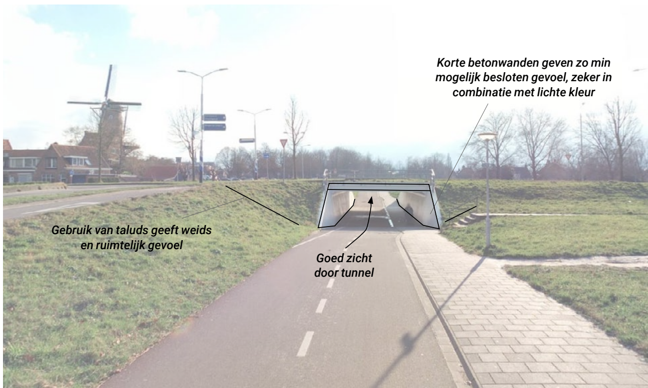
Fietstunnel bij de kruising tussen de Westerstraat en de Ringbaan West in Goes. Foto afkomstig van Streetsmart/Cyclomedia.
