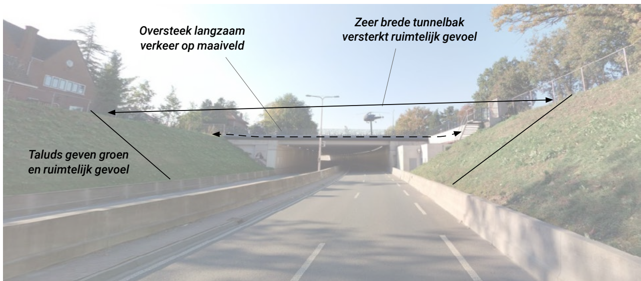
Onderdoorgang in de N237 bij Soesterberg. Foto afkomstig van Streetsmart/Cyclomedia.
