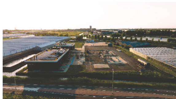
Aardwarmtelocatie, Trias Westland, Alkmaar
