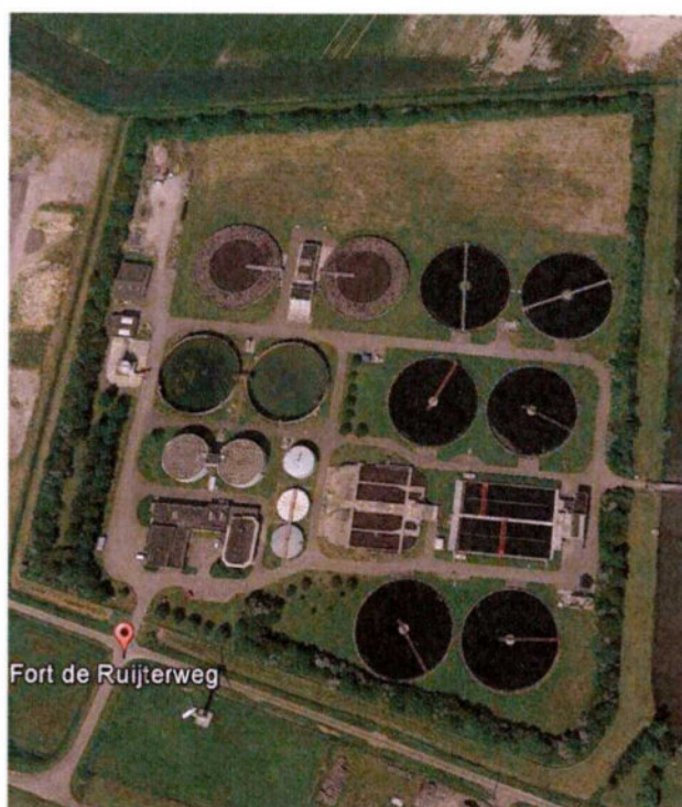
Figuur 2: Luchtopname van de bestaande RWZI Walcheren
