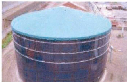
Figuur 8.3. Voorbeeld van een tank met een spankap en een ondersteuningsbok
