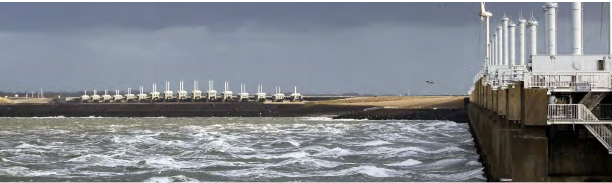
Man made karakter van dam en kering geven de Oosterscheldekering zijn specifieke identiteit
