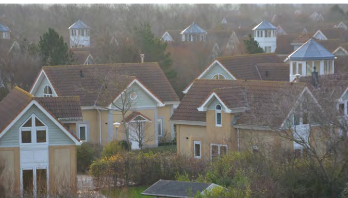
Vakantiepark de Banjaard
