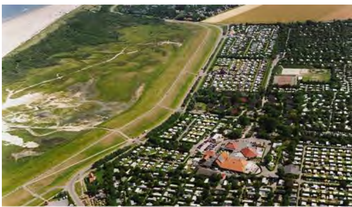
Beeld van de recreatieconcentratie Nieuwvliet Bad
