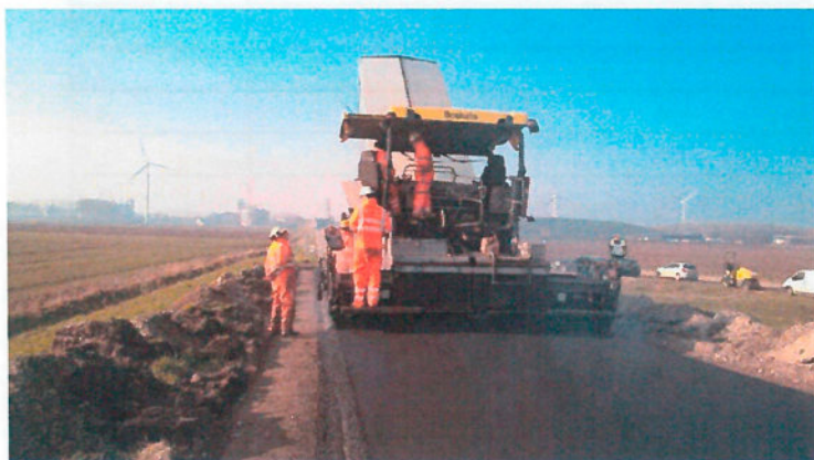
Asfalteren Spuikreekviaduct
