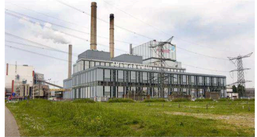
De Amercentrale van Geertruidenberg. Inmiddels is RWE AG de eigenaar. (Foto ANP XTRA)
