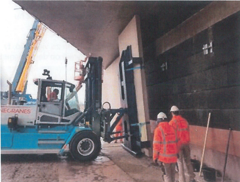
Foto: Plaatsen voorzetwanden viaduct KW 2 (zijde Nieuwdorp)
