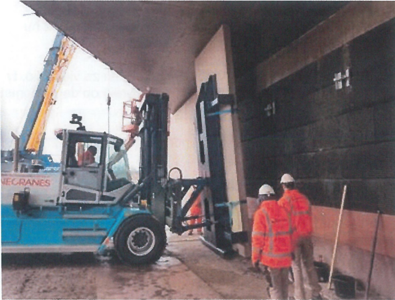
Foto: Plaatsen voorzetwanden viaduct KW 2 (zijde Nieuwdorp)
