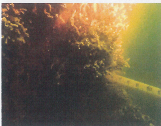
Figuur 0.7: Harde aangroei tot 6 cm.
