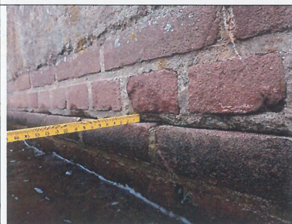
Figuur 0.3: Kierende lintvoeg.
