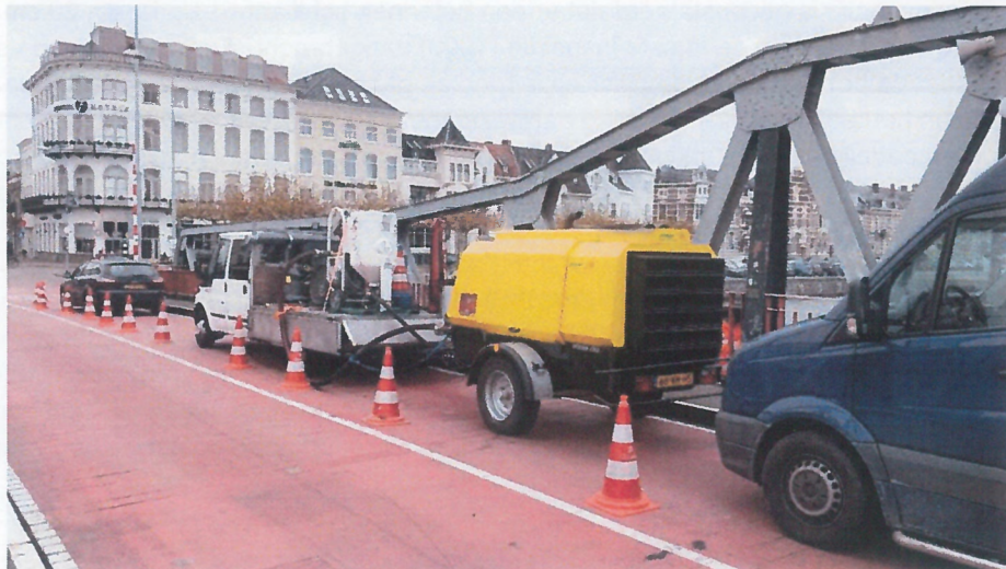
Figuur 4: Voertuigen op brug tijdens inspectie 20 november 2018
