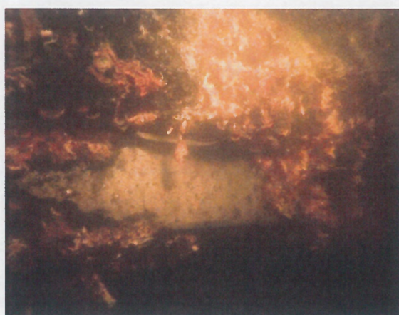
Figuur 0.8: Stalen profiel onderzijde betonnen schil.
