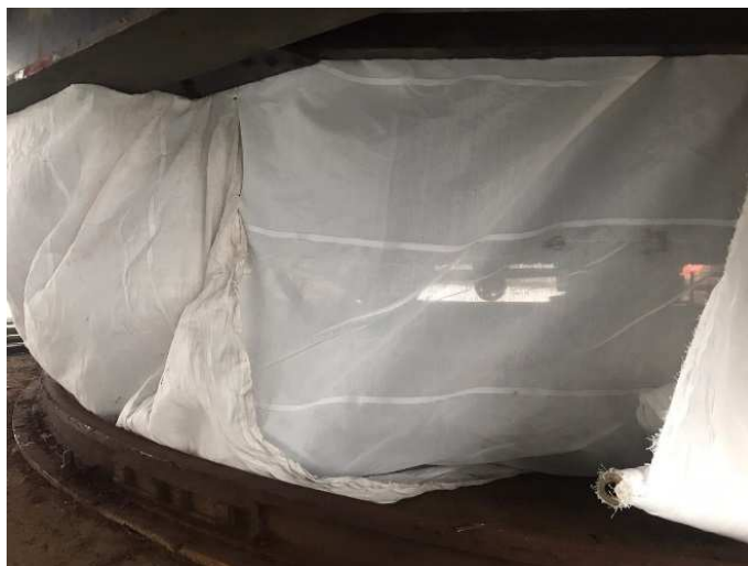
Figuur 3 De proeflocatie met ingepakt draaimechanisme
