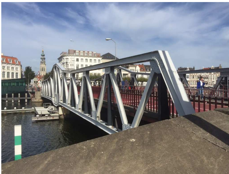
Figuur 1: Overzicht van de Stationsbrug Middelburg
