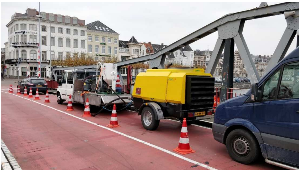
Figuur 4: Voertuigen op brug tijdens inspectie 20 november 2018
