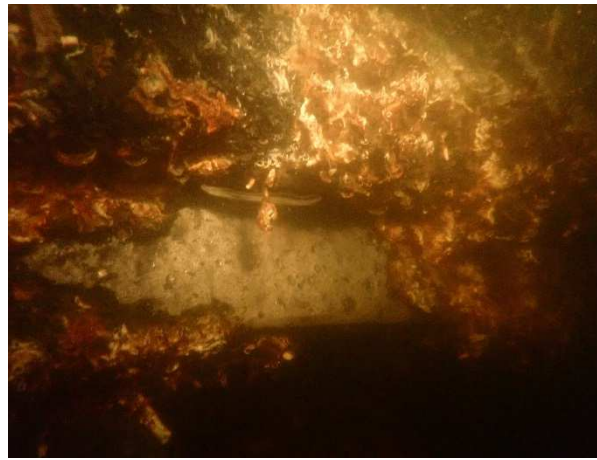
Figuur 0.8: Stalen profiel onderzijde betonnen schil.
