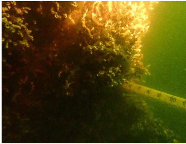
Figuur 0.7: Harde aangroei tot 6 cm.
