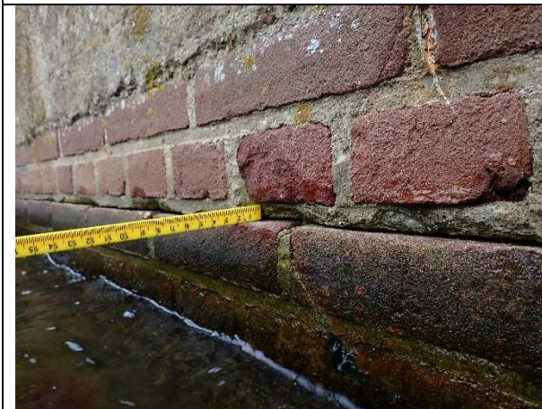
Figuur 0.3: Kierende lintvoeg.
