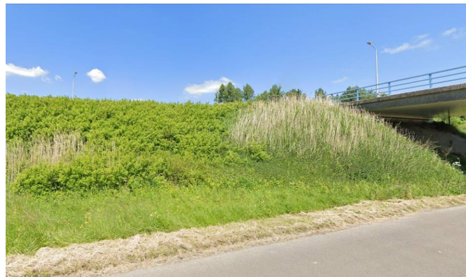
Afbeelding 19: ruigtevegetatie op talud viaduct N254 (Bernhardweg-West)
