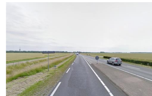
Grootschalige nieuwlandpolder Zuid-Beveland
