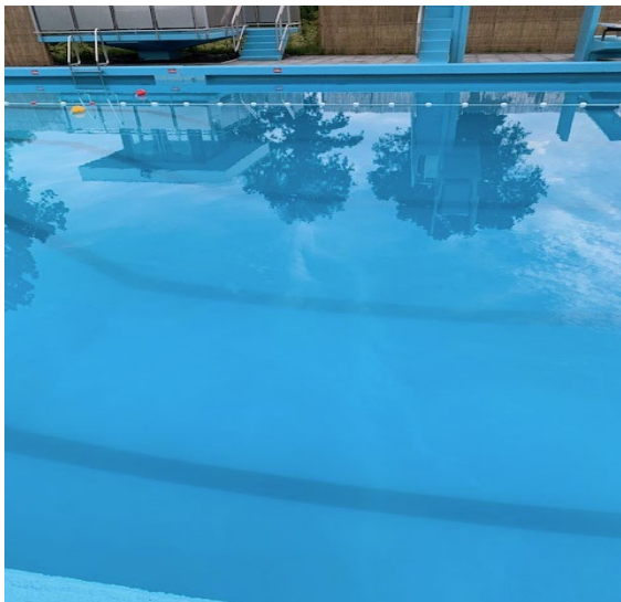
Bad leeg, na ontruiming
