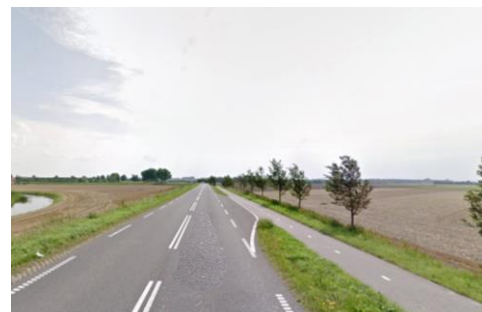
Kleinschalige Nieuwlandpolders Tholen
