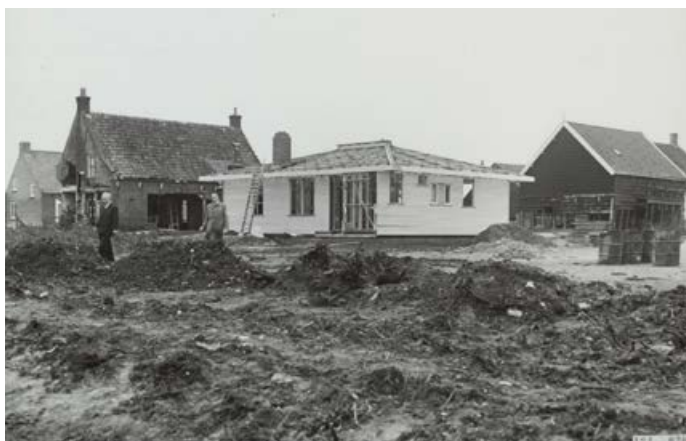
De Franse woning in aanbouw. Foto afkomstig van huidige bewoner
