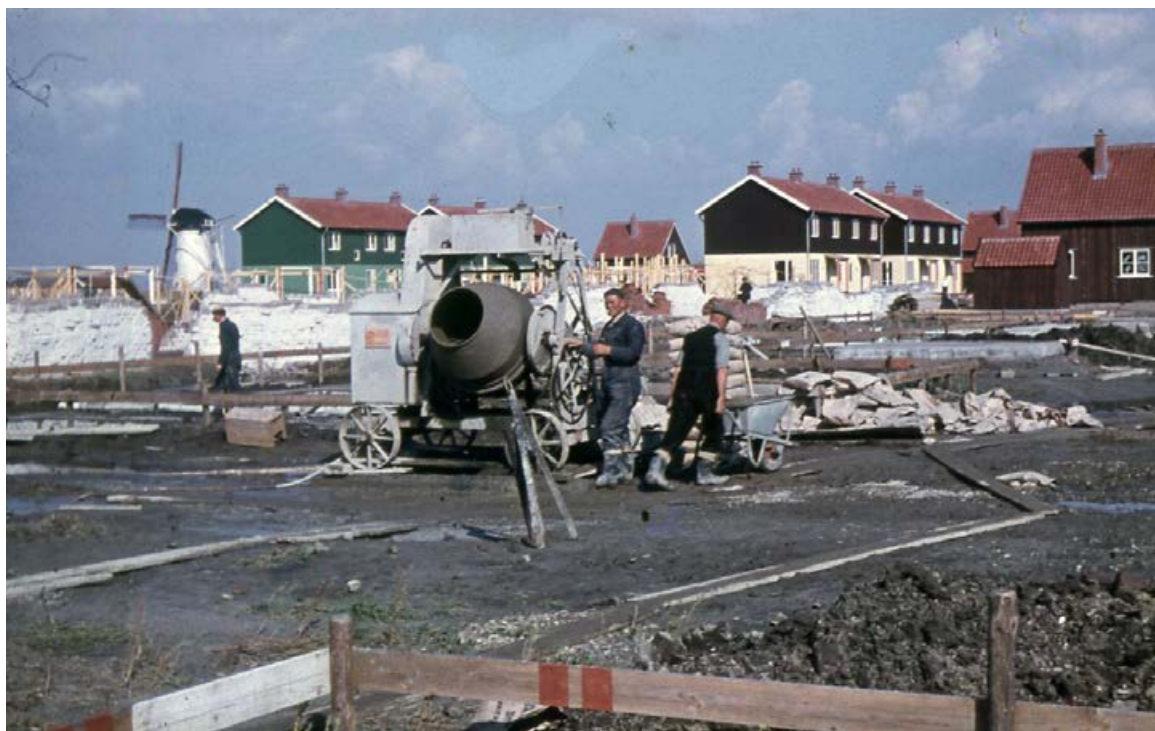
Woningen in aanbouw in Nieuwerkerk, Schouwen-Duiveland
