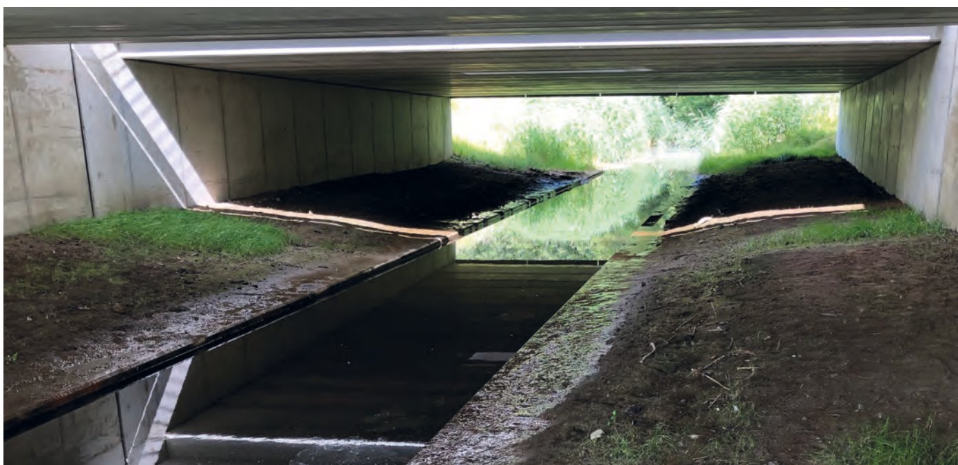
faunapassage onder viaduct
