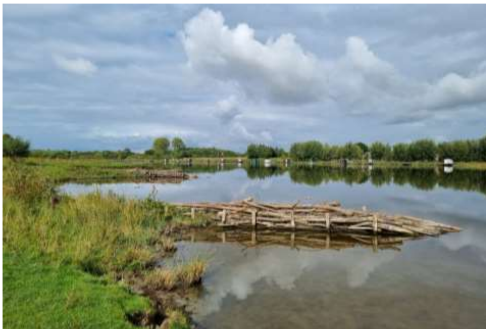
Figuur 16: Houtrillen in de Vogelkreek ten behoeve van het tegengaan van afbrokkeling van de zuidoever.
