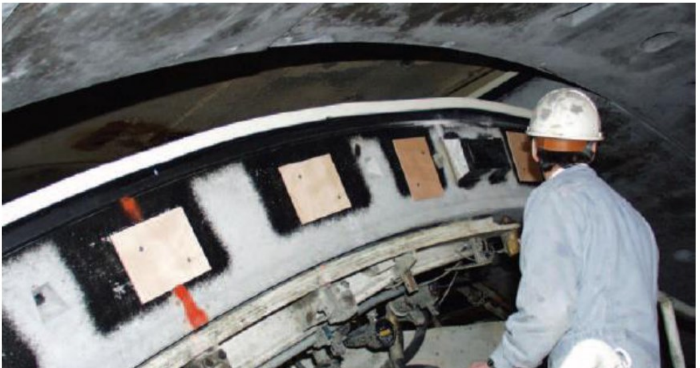
Figuur 8 Toepassing van triplex als ringvoeg materiaal
