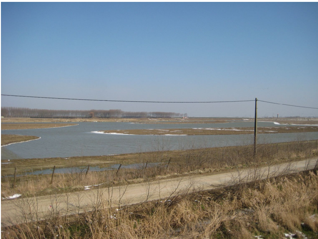
Foto 18b: Opnameplaats = ter hoogte van stop 18. Zicht op Prosperstraat en tijdelijke natuur Prosperpolder (in de verte de populierenrijen in de Hedwigepolder).
