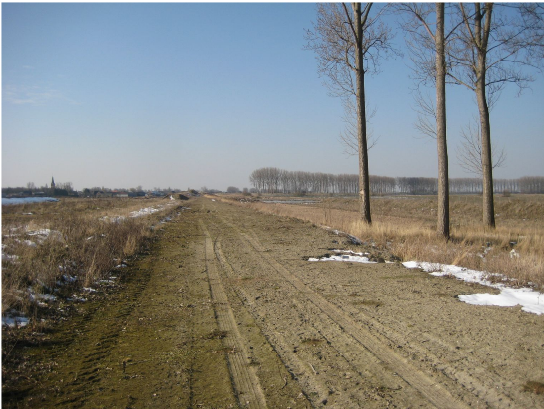
Foto 14b: Opnameplaats = ter hoogte van stop 14. Zicht vanaf Hedwigedijk richting Prosperpoldergedeelte buiten projectgebied.
