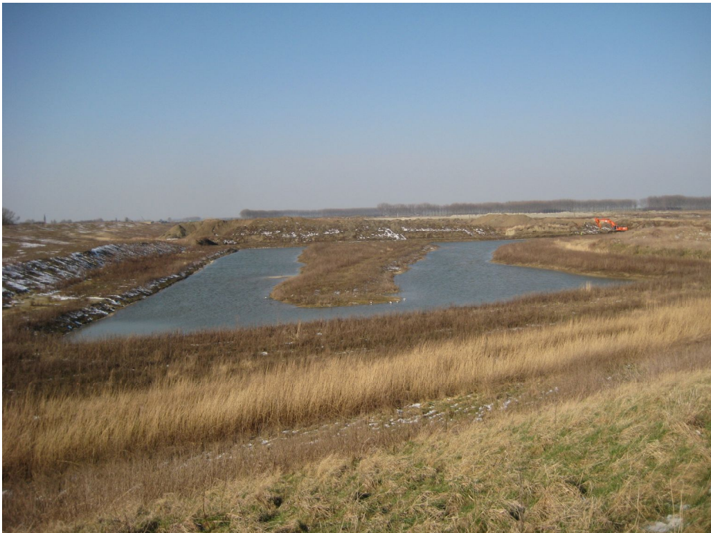
Foto 3: Opnameplaats = ter hoogte van stop 3. Zicht op afwateringsstructuur t.h.v. spuikom Prosperpolder.
