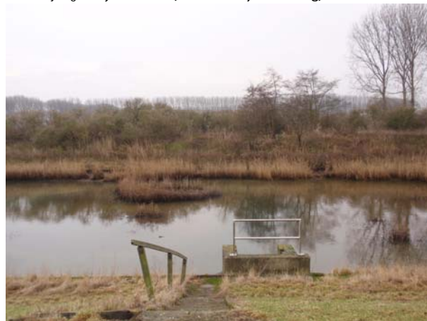
Fotonummer: 10 Omschrijving: Spuikom Lignestraat (zuidwestelijke richting)
