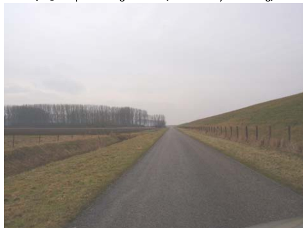
Fotonummer: 12 Omschrijving: Lignestraat (zuidwestelijke richting)
