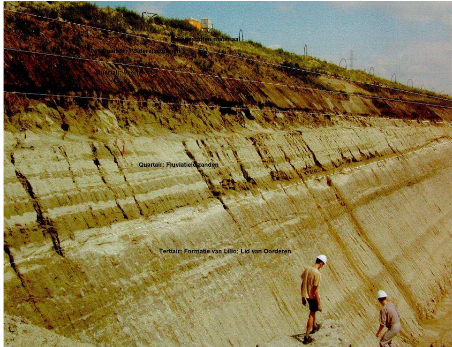
Figuur 6.5: Deurganckdok (juni 2000). De Formatie van Lillo is bedekt door fluviatiele zanden, veen, polderklei en opgespoten materiaal (Toelichtingen Geologisch Kaart van België Kaartblad 7).
